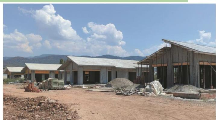
Duvarlar iç-dış çimento esaslı shotcrete sıva ile kaplanır. Döşeme üzerinde C30 hazır beton dökülür
