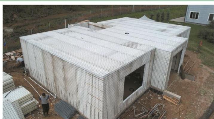
Zemine 20 cm ara ile ankrajlanır, monolitik yapı şecline çalışır, mükemmel deprem performansı gösterir
