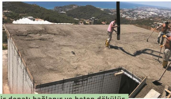
Statik hesap sonucu tespit edilen demir donatı bağlanır ve beton dökülür
