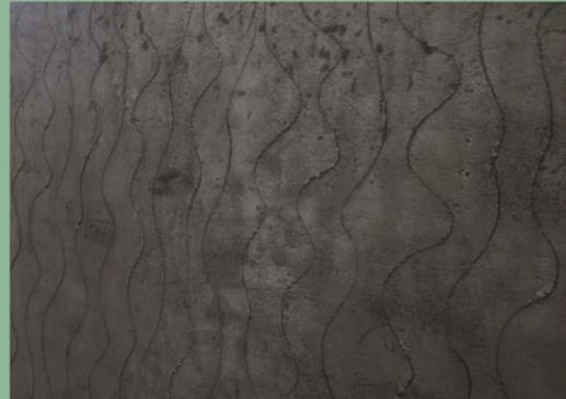
Kaba sıva tamamlandıktan sonra sıvanın periyodik olarak sulanması, sıvanın çivi veya mala ucu ile aralıklı olarak çizilmesi, sıvanın hararetini daha kolay atmasını ve ince sıvanın daha kolay yapışmasını sağlar ve rötre çatlaklarını önler.
