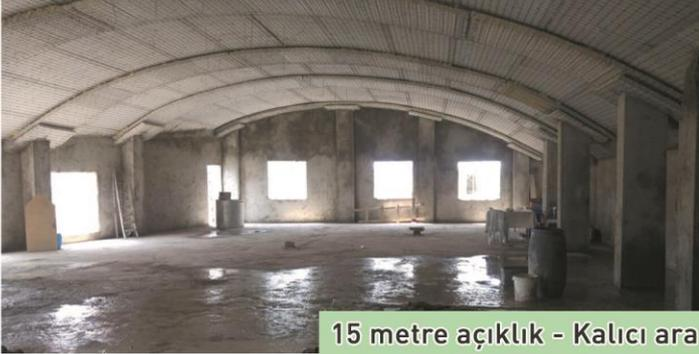
15 metre açıklık - Kalıcı ara kat konforuna sahip çatı katları
