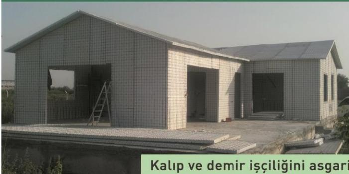
Kalıp ve demir işçiliğini asgariye indiren ısı yalıtımlı yapı sistemi
