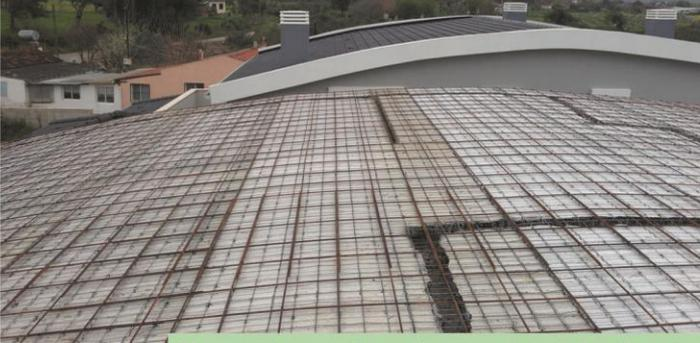
Duvarların üzerine gelen hizalarda E.P.S boşaltılıp hatıl kesiti oluşturulur
