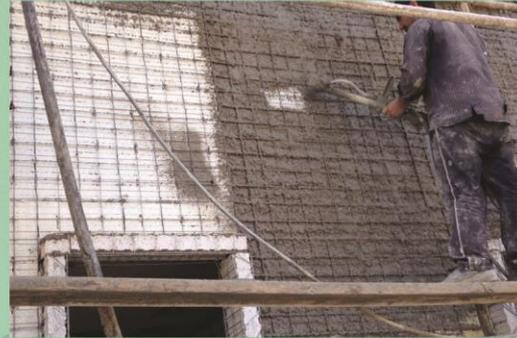
Püskürtme sıva makinesi ile sıva uygulaması
