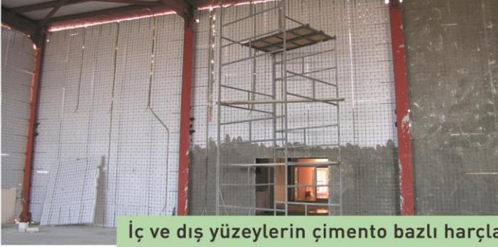
İç ve dış yüzeylerin çimento bazlı harçla sıvanması el ile veya makine ile yapılabilir
