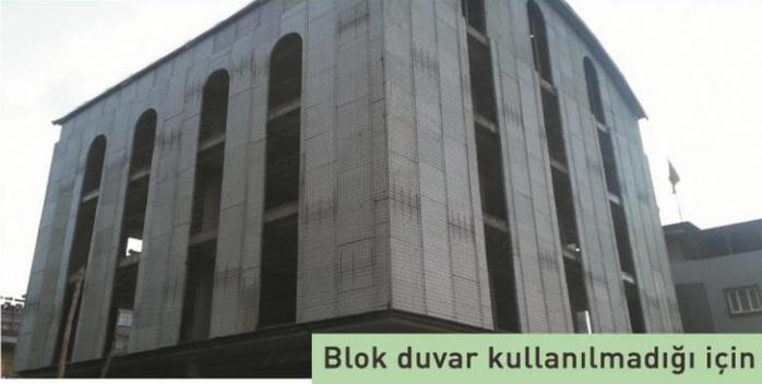
Blok duvar kullanılmadığı için %5 - 10 arası alan kazanımı sağlar
